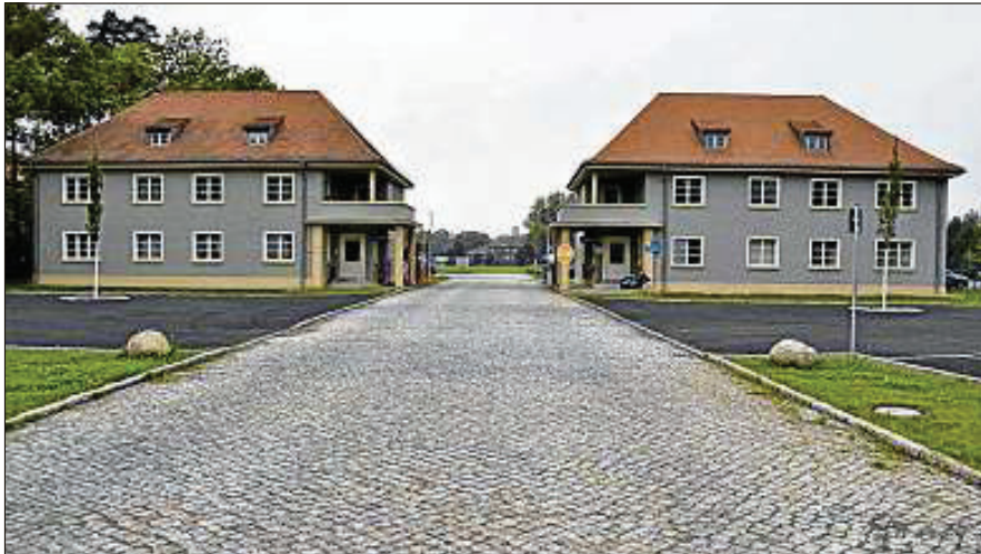
Früherer Bausoldatenstandort: auf dem Gelände der heutigen Polizeifachhochschule arbeitete Ulrich Lörzer zu Weihnachten 1982 als Heizer. Bei der Wache melden sich in letzter Zeit immer wieder ehemalige Bausoldaten, um sich zu erinnern. Fotos (2): Dagmar Möbius
